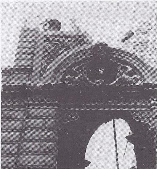
Eën van de toegangspoorten tot de Galerij tijdens de afbraak.
